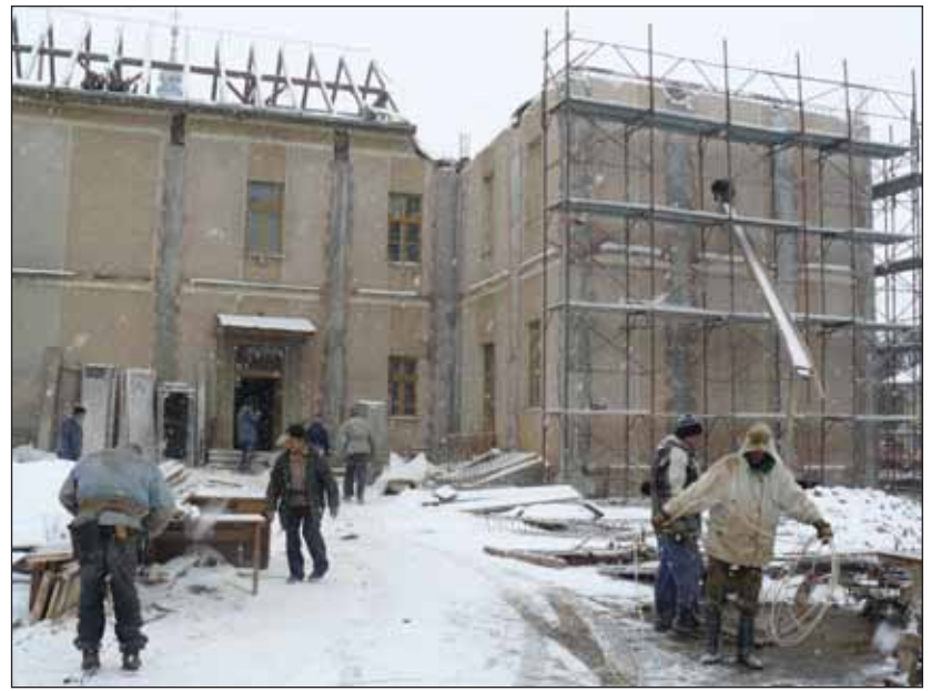
Renovierungsarbeiten am alten Schulgebäude
