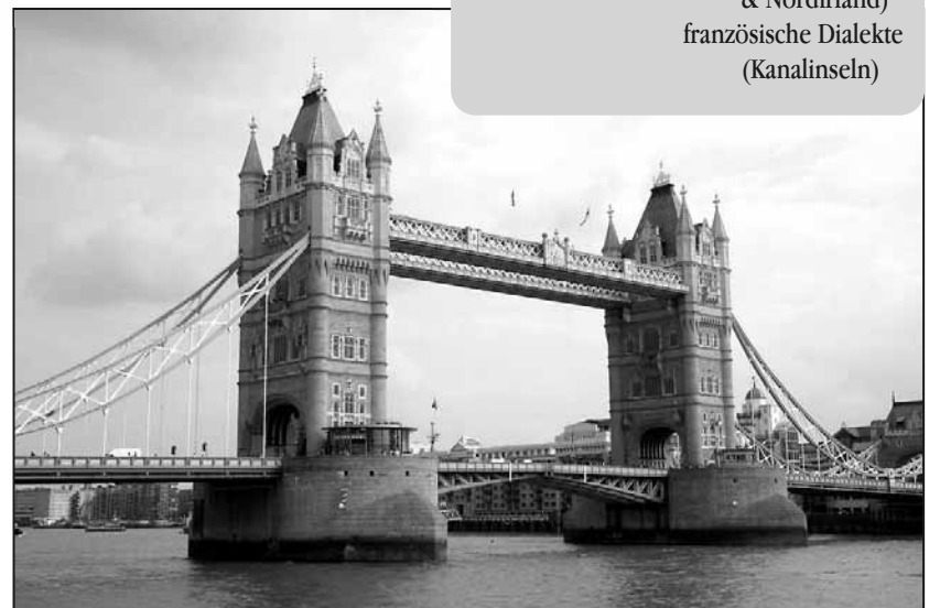
Die Tower-Bridge in London wurde vor 116 Jahren eröffnet. Die Fahrbahn kann in der Mitte geöffnet werden um größeren Schiffen die Durchfahrt zu ermöglichen.
